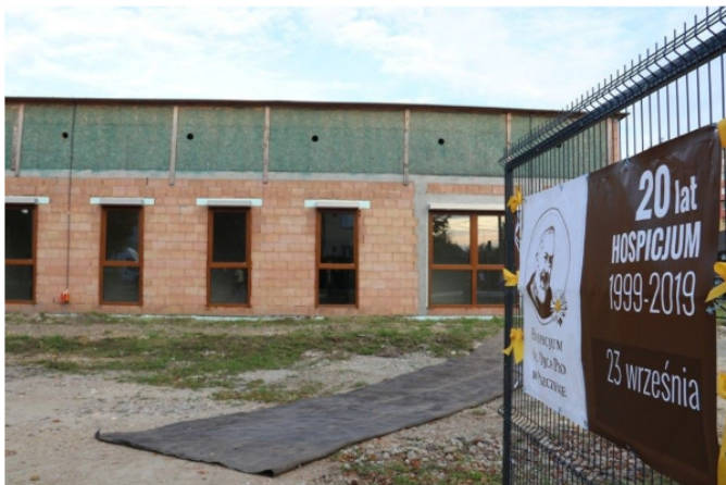
Stan budowy Domu Ojca Pio we wrześniu 2019 roku
